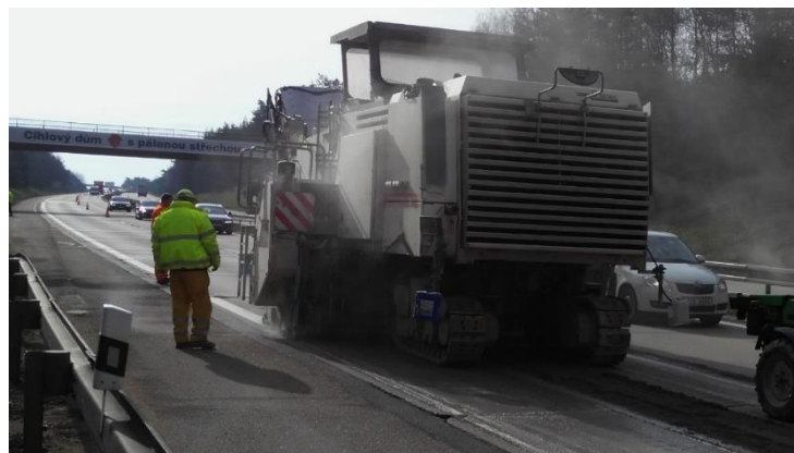
Zrovnávanie betónových vozoviek, na ktorých sa vyskytli „schodky“ na dilatačných špárach
