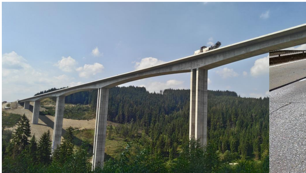
Zrovnávanie betónového povrchu pri stavbe nosnej konštrukcie mostov
