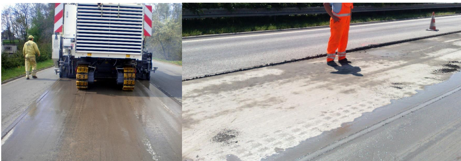
Zrovnávanie asfaltového povrchu
