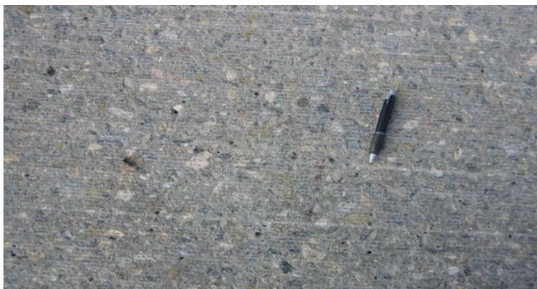
Zrovnávanie betónových vozoviek, na ktorých sa vyskytli „schodky“ na dilatačných špárach
